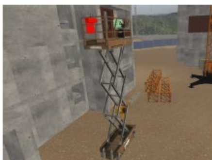
Рисунок 22. Ножничный подъемник работает
